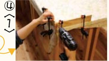
④<1> B側板とC棚板をつけます。クランプで部材を固定するとずれにくくなります。
